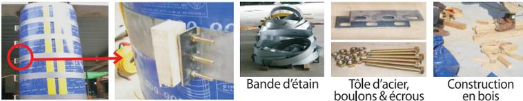
Fixer avec un raccord de bande dédiée aux intervalles spécifiés. Insérez du fer plat entre les boulons et les écrous et renforcez l'intervalle entre les bandes avec volige.
