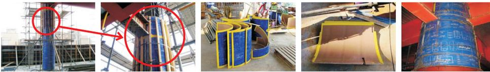
Utilisez la bande d'étain fixe jusqu'à ce que la partie inférieure de la poutre. la zone de raccordement du faisceau peut être fixée l'aide de volige ou légèrement souder à l'extrémité des petits fils. il peut aussi être utilisé en coupant la forme du cadre en acier en tirant pleinement parti de la transformation facile du carton
